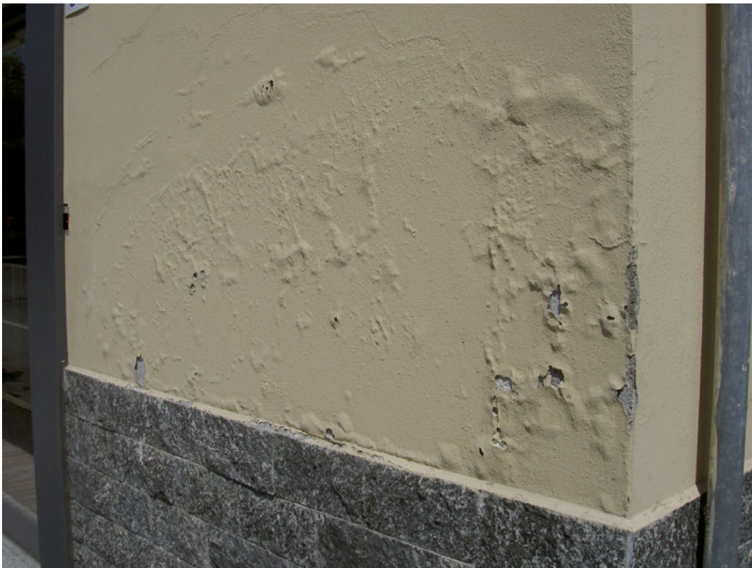
Il rivestimento della superficie inferiore della muratura mediante mattonelle di pietra non può arrestare il degrado dell'intonaco causato dall'umidità di risalita.
