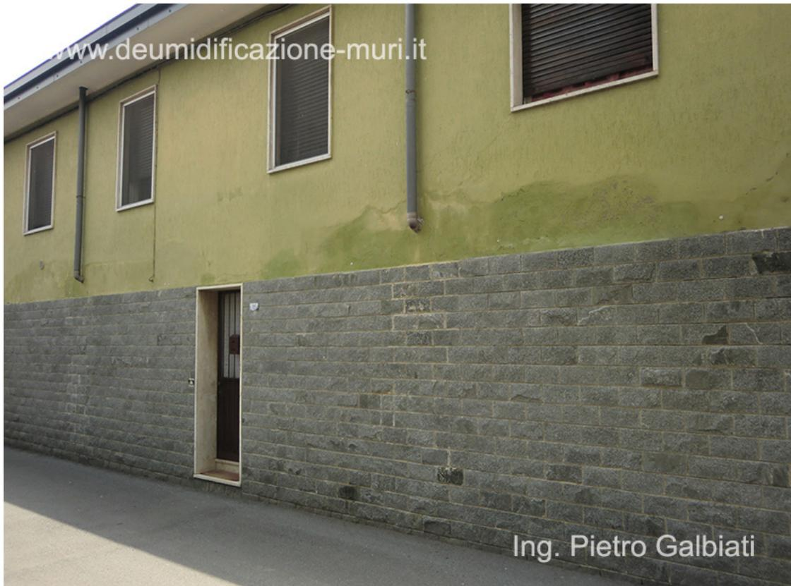
In una muratura soggetta al problema dell'umidità di risalita si è individuato un altro particolare fenomeno: la presenza di una **differenza di potenziale elettrico** (ovvero una tensione elettrica) tra il **terreno** (polo positivo) e la **muratura** umida soprastante (polo negativo).
