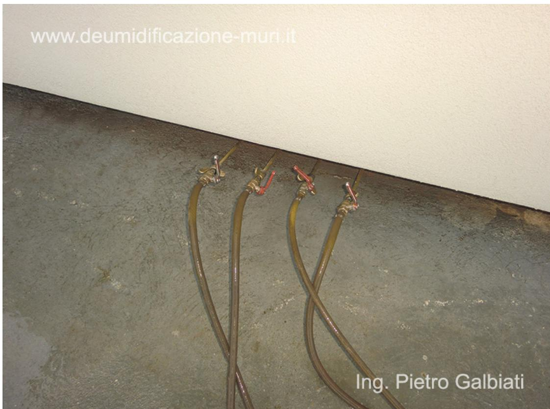
Barriera chimica mediante iniezioni di resine siliconiche al di sotto del cappotto, senza la sua rimozione e danneggiamento.
