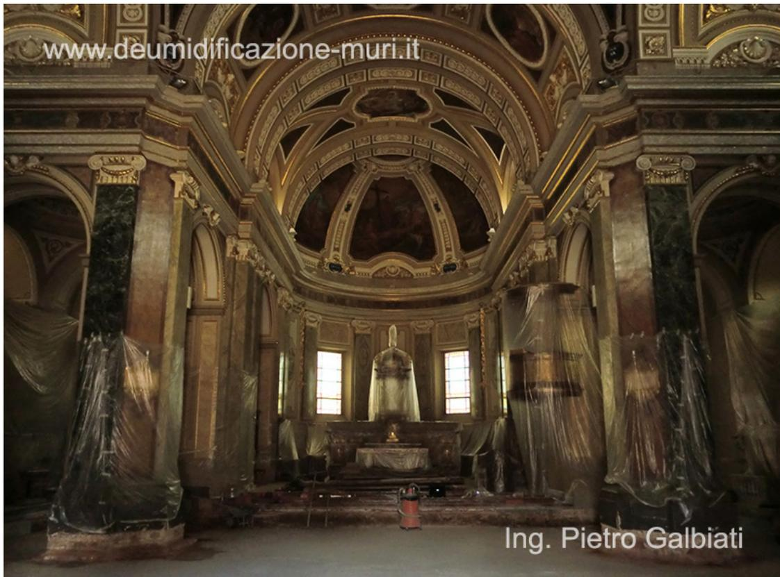
Barriera chimica mediante iniezioni di resine siliconiche alla base delle murature e delle colonne all'interno di una chiesa.
