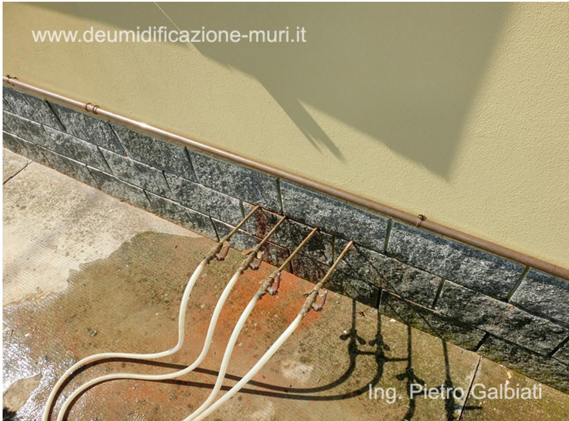
Barriera chimica mediante iniezioni di resine siliconiche tra le fughe delle beole, senza la loro rimozione e danneggiamento.
