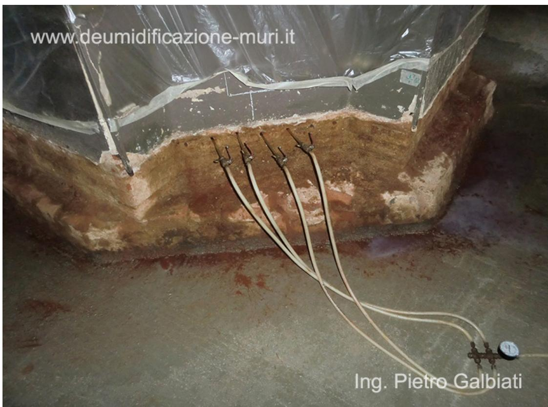
Barriera chimica mediante iniezioni di resine siliconiche al di sotto dei rivestimenti e delle pitture esistenti, senza il loro danneggiamento.
