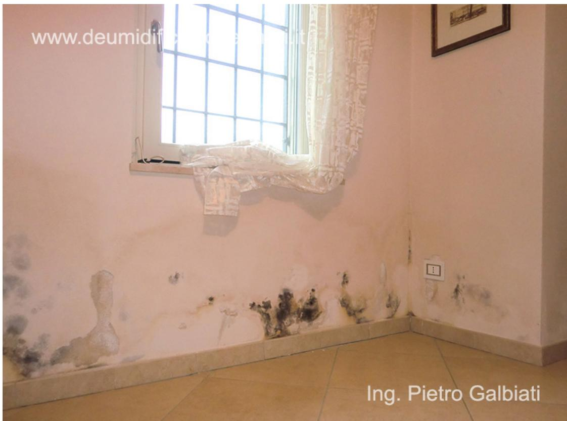
Danni causati dall'umidità di risalita: effetto bagnato, distacco della tinteggiatura e della stabilitura, formazione di muffe.
