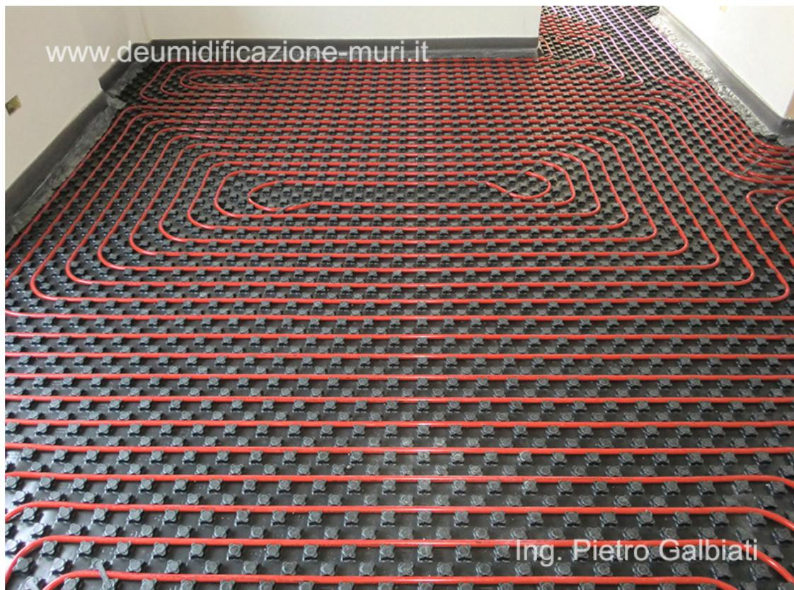
Un impianto di riscaldamento radiante a pavimento non può arrestare il problema dell'umidità di risalita.
