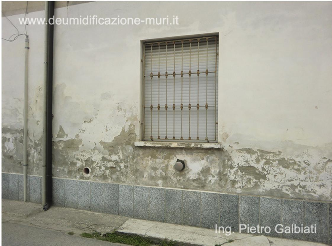
Il rivestimento in lastre di granito alla base della muratura non può certamente arrestare il problema dell'umidità di risalita.
