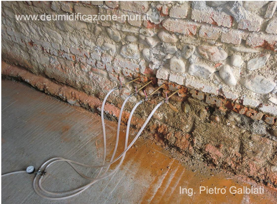
Barriera chimica mediante iniezioni di resine silconiche su una muratura in mattoni pieni in laterizio e sassi, operando dall'interno, dopo la rimozione dell'intonaco ammalorato.
