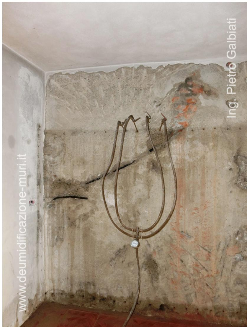
La foto ritrae una muratura in calcestruzzo di un locale quasi totalmente interrato, su cui è stata eseguita la barriera chimica (mediante iniezioni di resine siliconiche) su due livelli ovvero a quota del pavimento interno e a quota della pavimentazione esterna.
