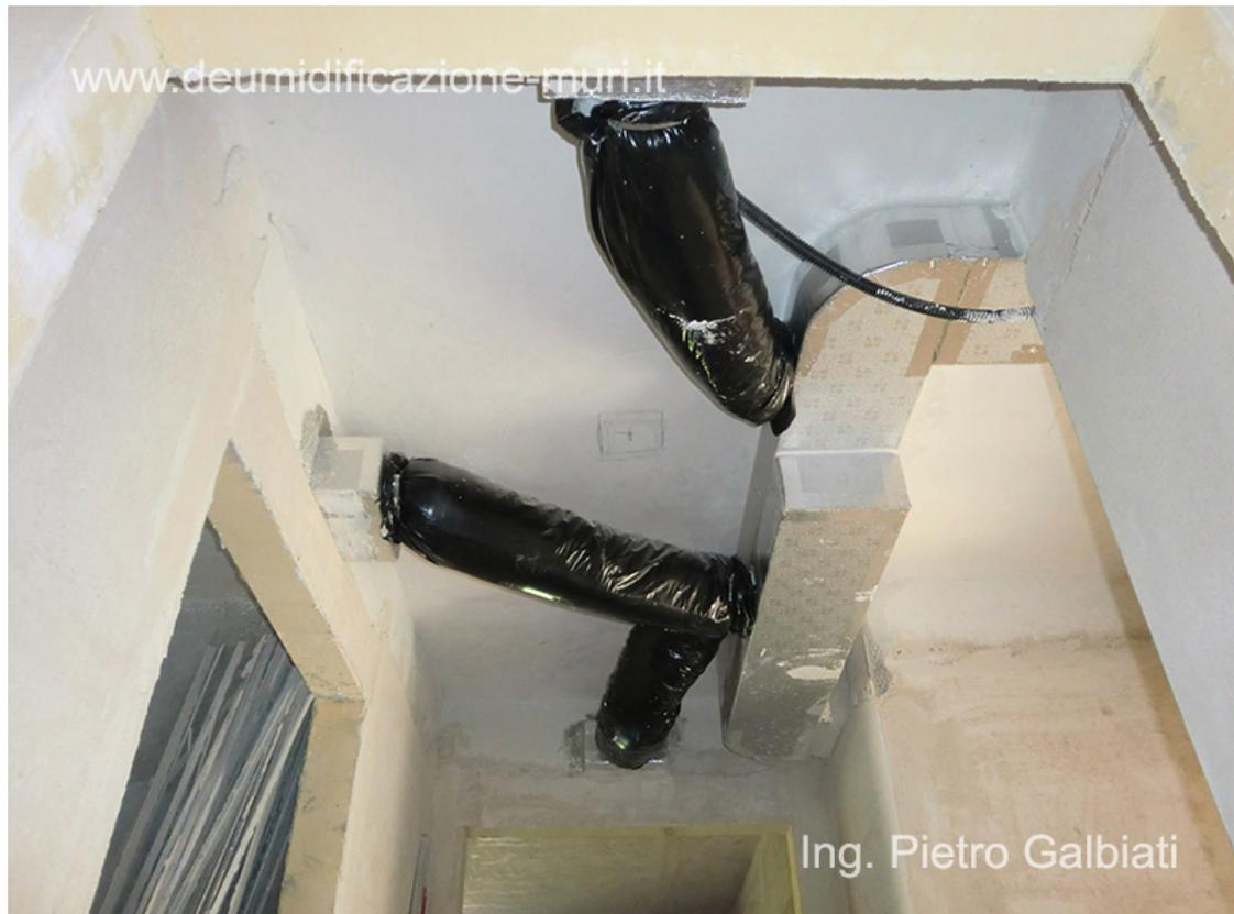
Un impianto di ventilazione meccanica controllata non può arrestare il problema dell'umidità di risalita.
