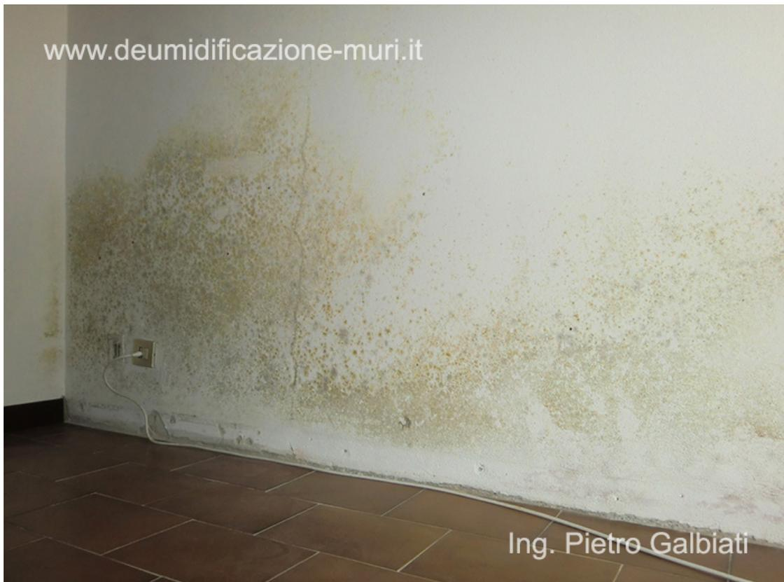
Formazione di muffa sulla superficie inferiore di una muratura soggetta al problema dell'umidità di risalita dal terreno.
