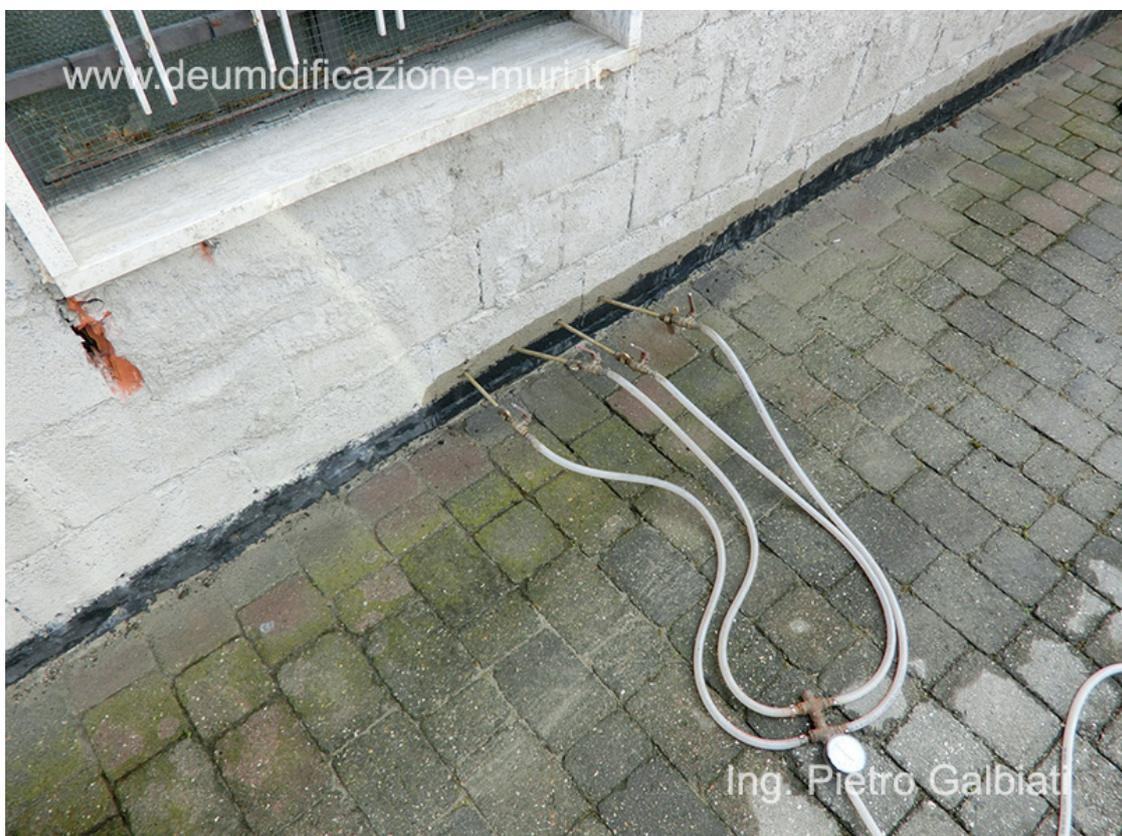
Barriera chimica mediante iniezioni di resine siliconiche su una muratura in blocchi in calcestruzzo, operando dall'esterno, dopo la rimozione dell'intonaco ammalorato.
