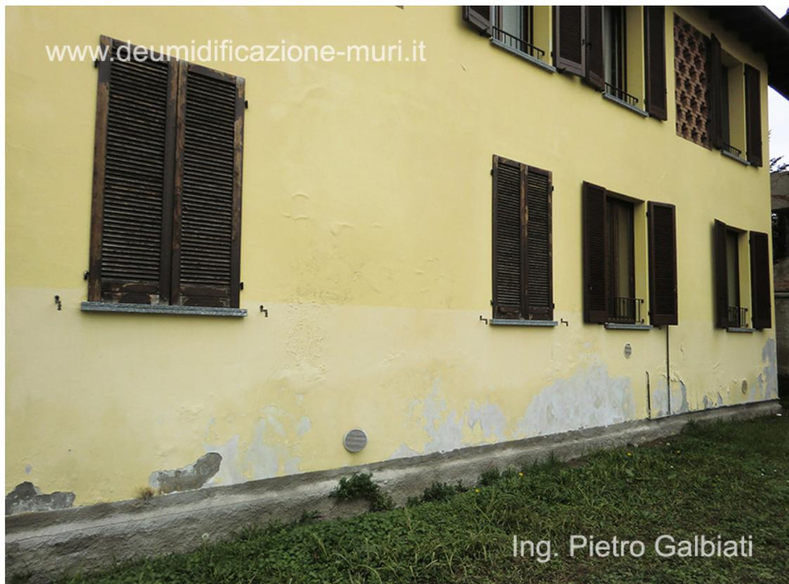
La realizzazione di un marciapiede lungo la muratura può solo limitare (ma non arrestare) il problema dell'umidità di risalita. In questo caso in presenza di un marciapiede il degrado dell'intonaco sarebbe probabilmente minore ma non assente.
