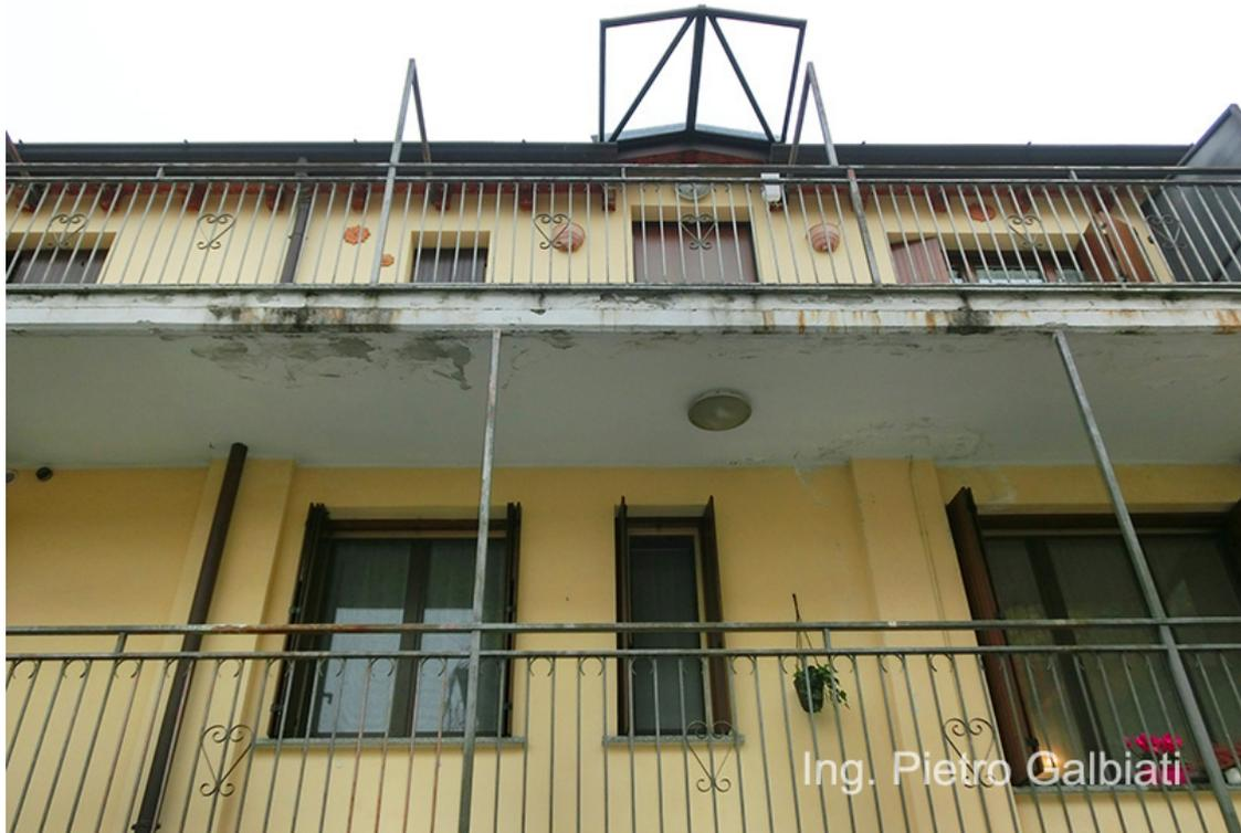
Infiltrazione di acqua piovana lungo un ballatoio.
