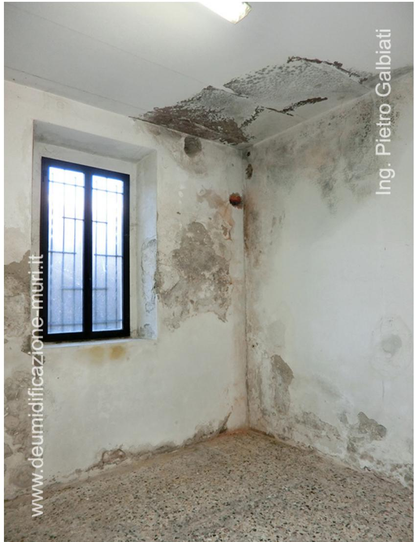
L'**umidità residua da costruzione** è l'umidità (acqua allo stato liquido) ancora presente in una muratura (in un massetto, in un solaio, in un sottofondo) di un nuovo edificio, che andrà progressivamente a ridursi a seguito del processo di evaporazione.
