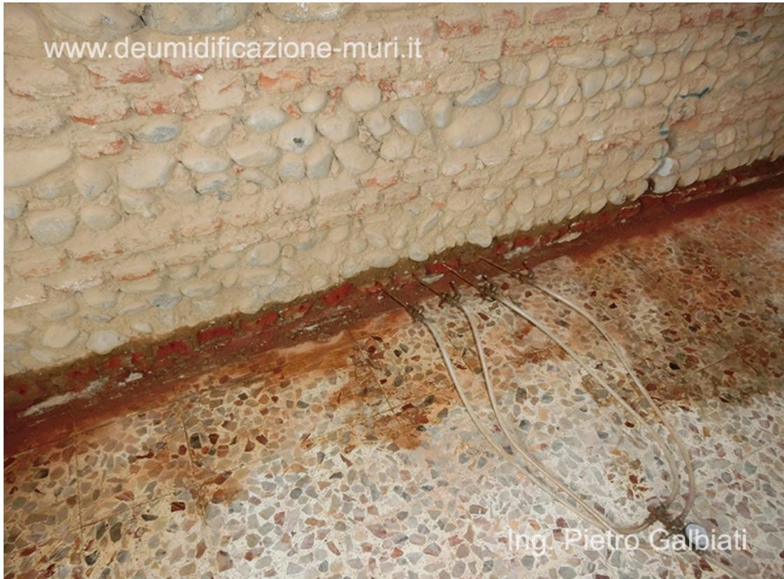
Barriera chimica mediante iniezioni di resine silconiche su una muratura in sassi e mattoni pieni in laterizio, operando dall'interno, dopo la rimozione dell'intonaco ammalorato.
