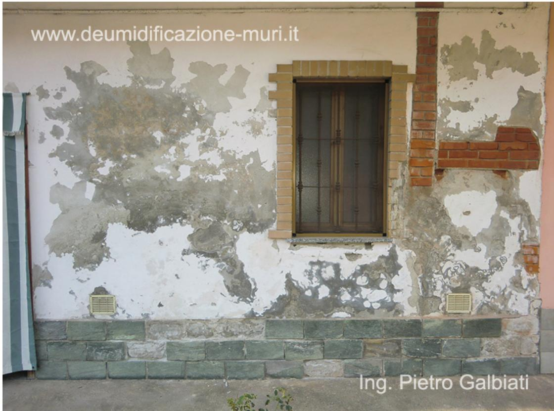
Danni causati dall'umidità di risalita: distacco della tinteggiatura, della stabilitura e delle beole.
