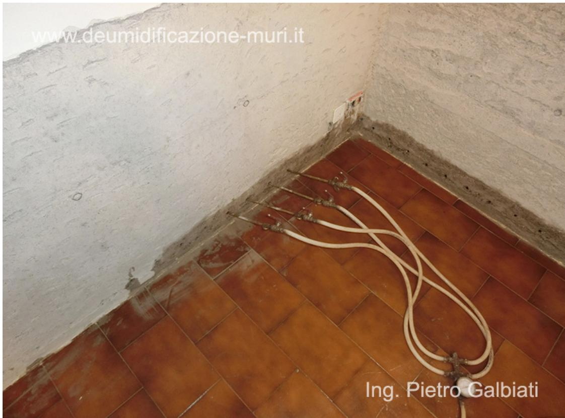
Barriera chimica mediante iniezioni di resine siliconiche su una muratura in calcestruzzo, operando dall'interno, dopo la rimozione dell'intonaco ammalorato.
