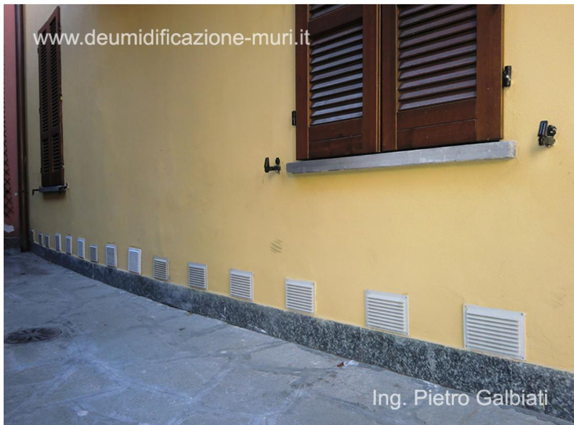
La realizzazione di fori di aerazione alla base della muratura può solo limitare (ma non arrestare) il problema dell'umidità di risalita.
