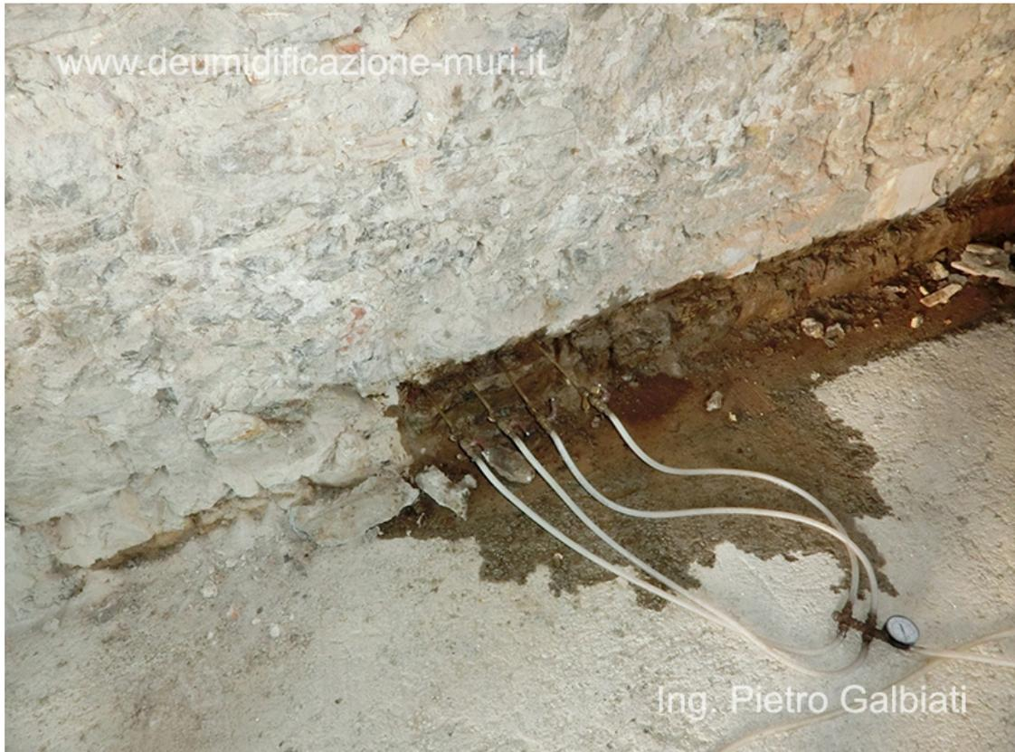
Barriera chimica mediante iniezioni di resine siliconiche su una muratura in pietre, operando dall'interno, dopo la rimozione dell'intonaco ammalorato.
