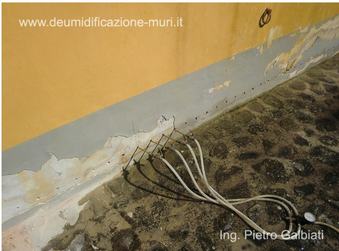
Barriera chimica mediante iniezioni di resine siliciche su una muratura in mattoni pieni in laterizio e sassi, operando dall'esterno, prima della rimozione dell'intonaco ammalorato.
