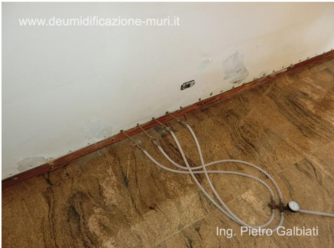
Barriera chimica mediante iniezioni di resine silconiche su una muratura in mattoni pieni in laterizio, operando dall'interno, prima della rimozione dell'intonaco ammalorato.
