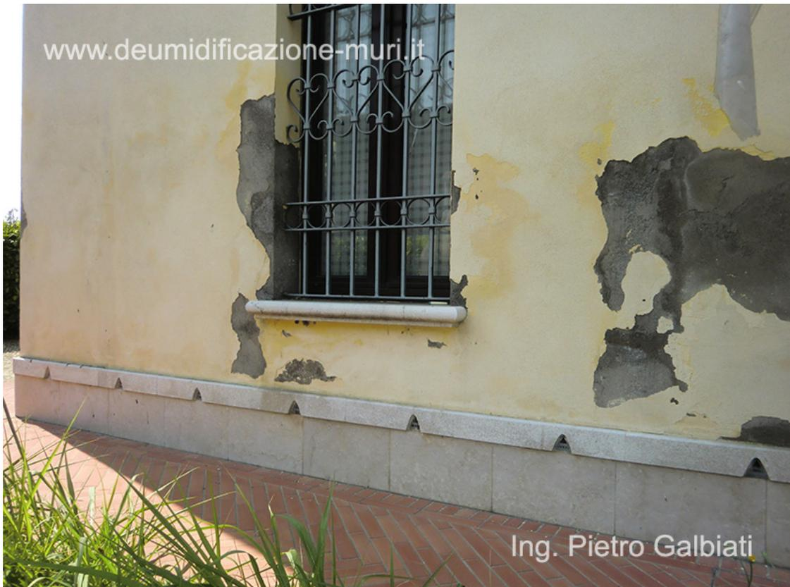
Il rivestimento in lastre di marmo alla base della muratura e la realizzazione di fori di aerazione non sono in grado di arrestare il problema dell'umidità di risalita.
