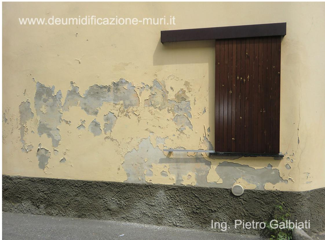
La strollatura della superficie inferiore della muratura non può certamente arrestare il problema dell'umidità di risalita.
