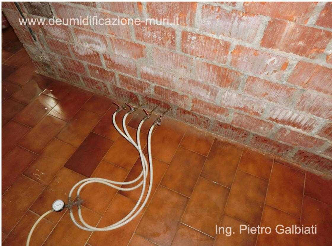
Barriera chimica mediante iniezioni di resine silconiche su una muratura in blocchi semipieni in laterizio, operando dall'interno, dopo la rimozione dell'intonaco ammalorato.
