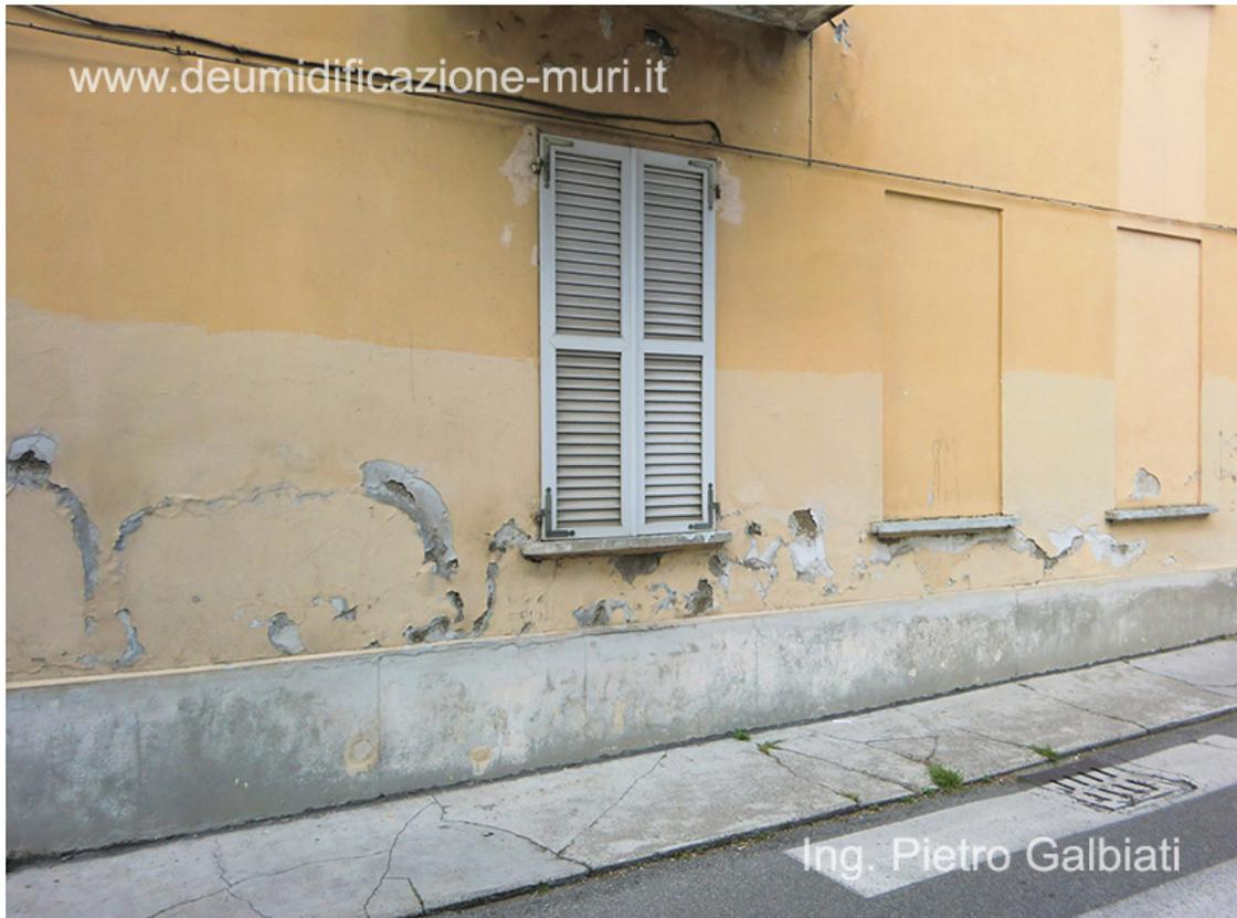
Il rivestimento in lastre di cemento alla base della muratura non può certamente arrestare il problema dell'umidità di risalita.
