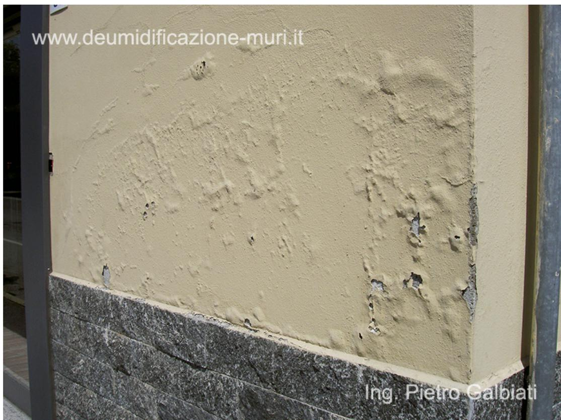
Danni causati dall'umidità di risalita: formazione di bolle sulla tinteggiatura, distacco della tinteggiatura.
