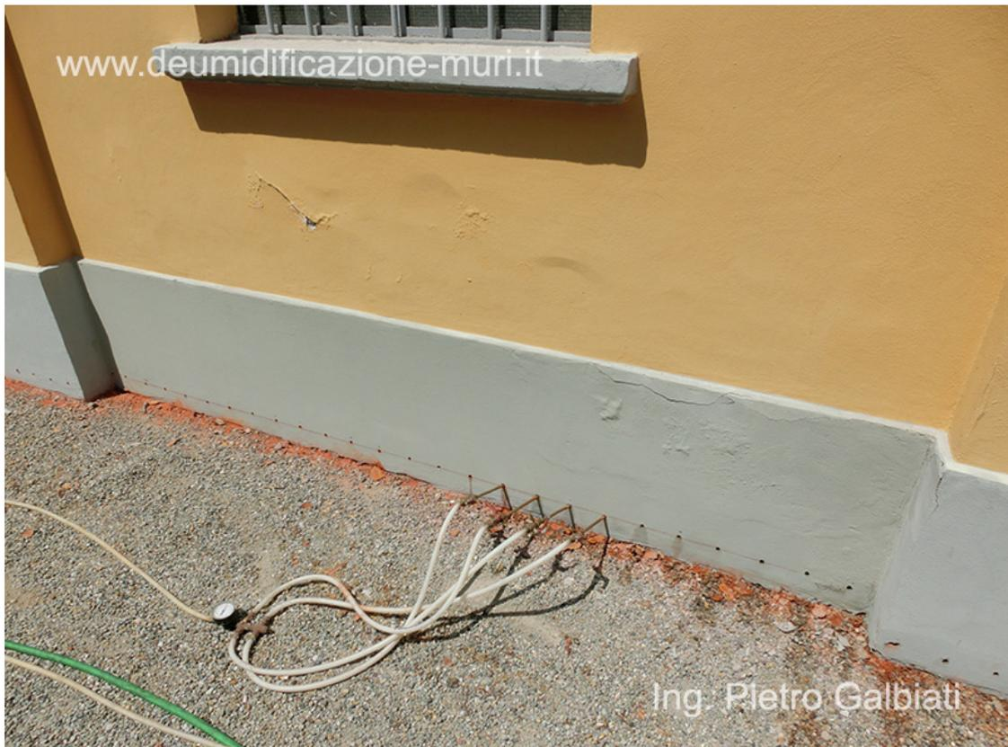
Barriera chimica mediante iniezioni di resine siliconiche su una muratura in mattoni pieni in laterizio, operando dall'esterno, prima della rimozione dell'intonaco ammalorato.
