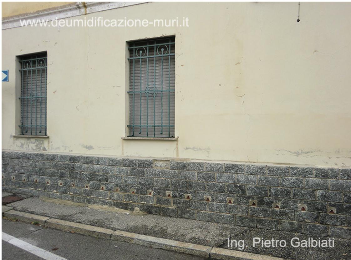
Il rivestimento in beole alla base della muratura e la realizzazione di fori di aerazione non sono in grado di arrestare il problema dell'umidità di risalita.
