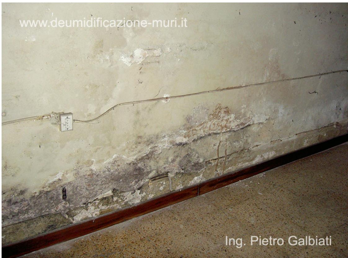
Danni causati dall'umidità di risalita: distacco della tinteggiatura, della stabilitura e dell'intonaco, formazione di muffe.
