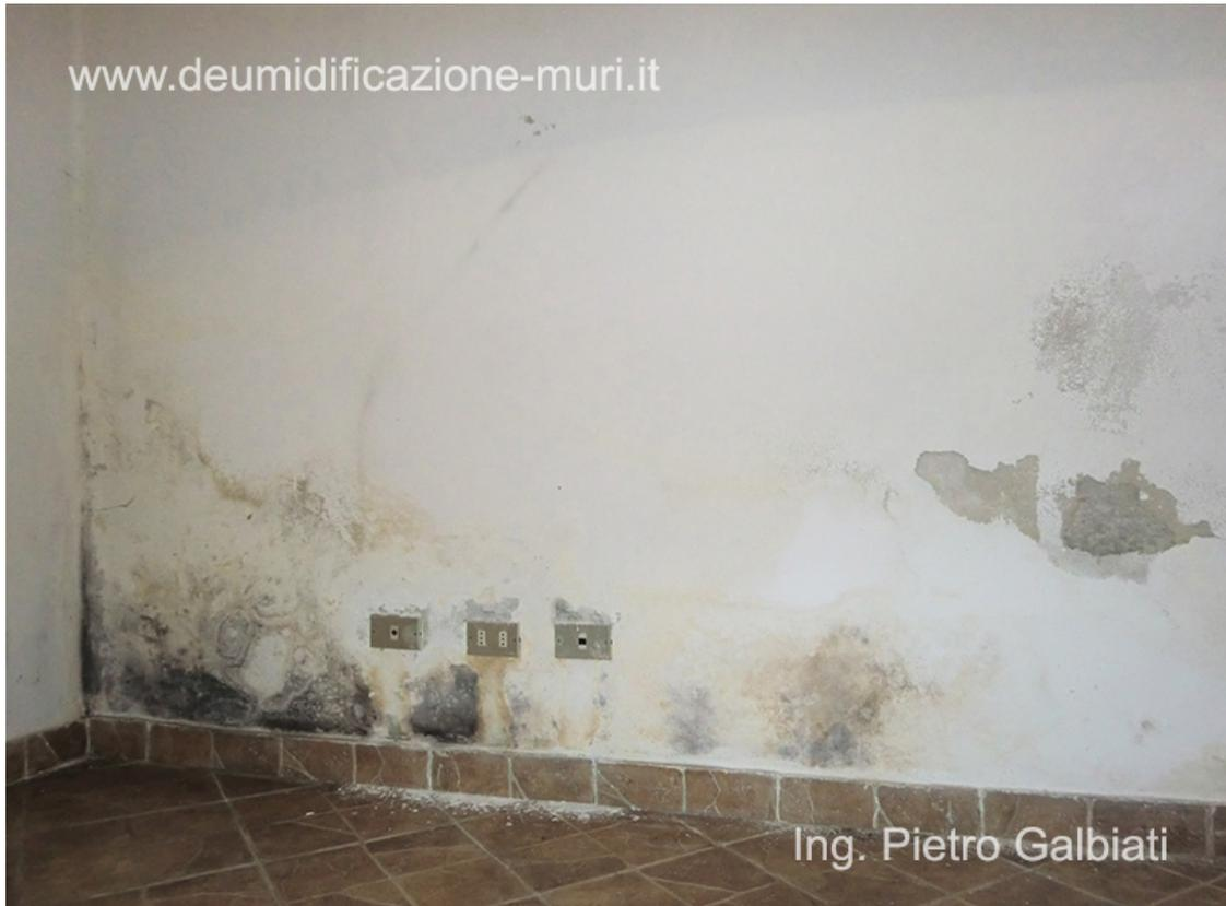
Danni causati dall'umidità di risalita: distacco della tinteggiatura e della stabilitura, formazione di muffe.
