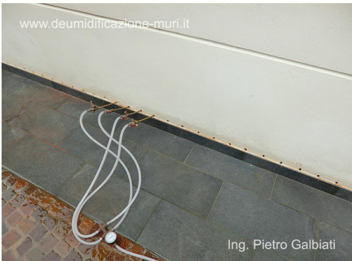
Barriera chimica mediante iniezioni di resine siliconiche su una muratura in mattoni pieni in laterizio, operando dall'esterno, per prevenire il degrado dell'intonaco recentemente ripristinato.
