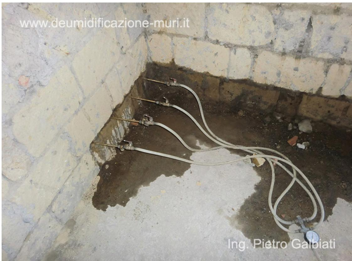
Barriera chimica mediante iniezioni di resine siliconiche su una muratura in blocchi di tufo, operando dall'interno, dopo la rimozione dell'intonaco ammalorato.
