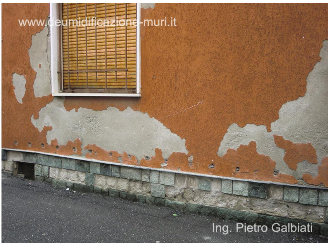
Il rivestimento in beole alla base della muratura, la realizzazione di fori di aerazione e l'applicazione di una pittura poco traspirante non sono in grado di arrestare il problema dell'umidità di risalita.
