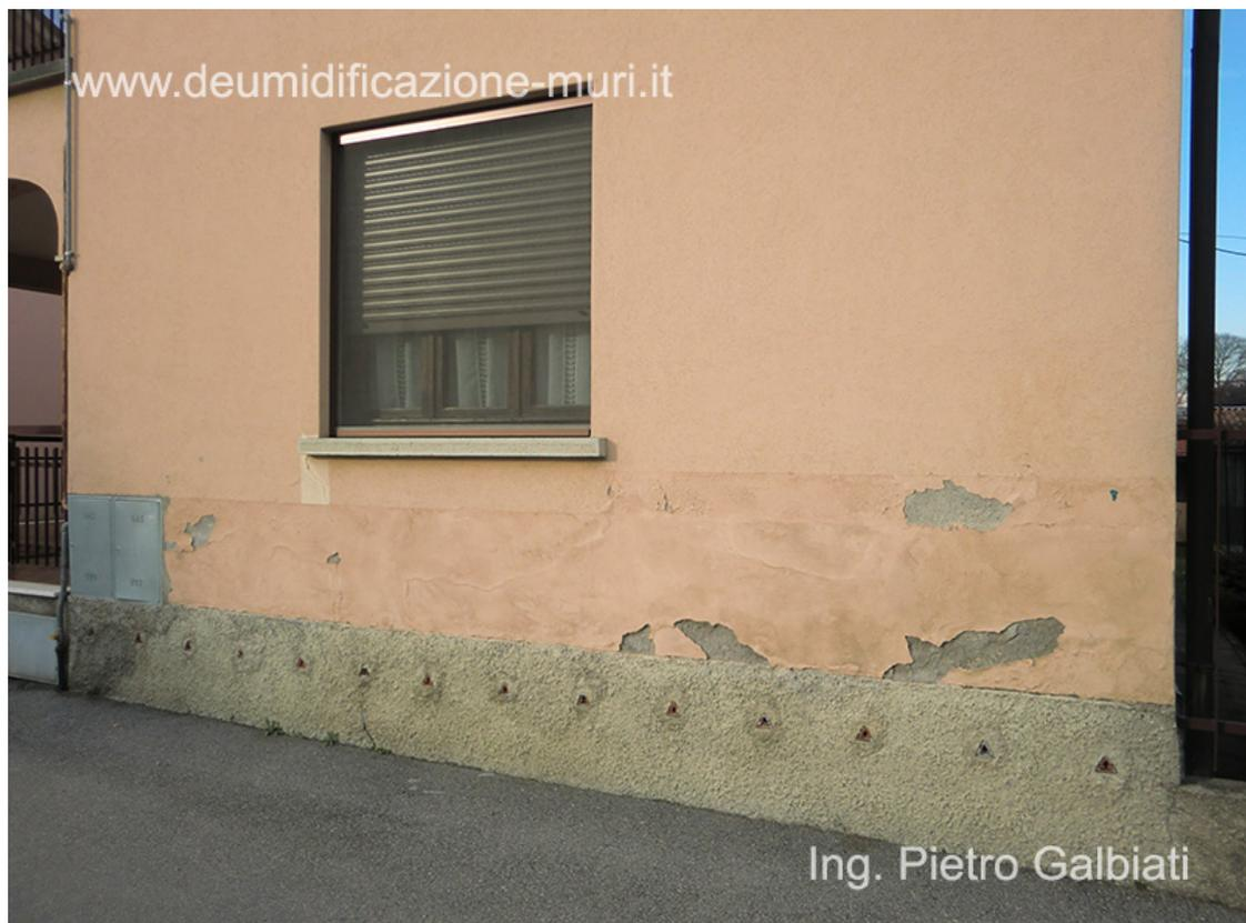
La strollatura della superficie inferiore della muratura e la realizzazione di fori di aerazione non sono in grado di arrestare il problema dell'umidità di risalita.
