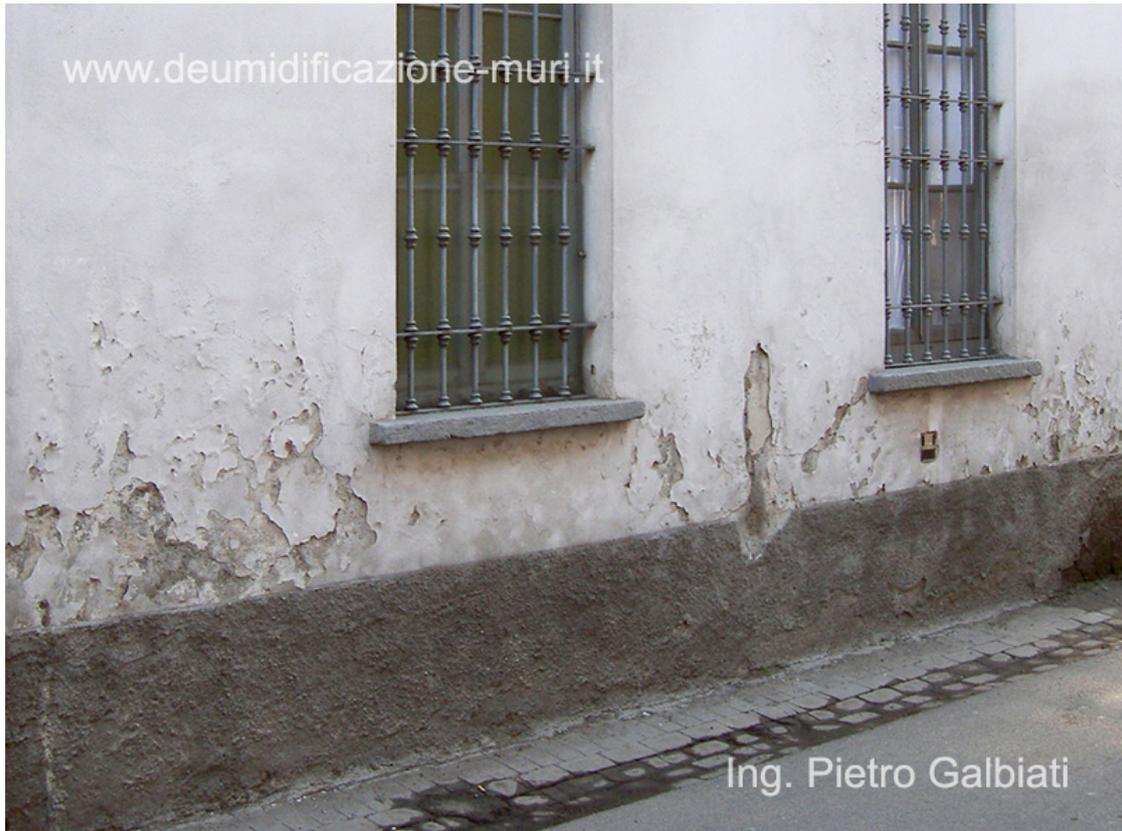
Danni causati dall'umidità di risalita: effetto bagnato, formazione di bolle sulla tinteggiatura, distacco della tinteggiatura e della stabilitura.
