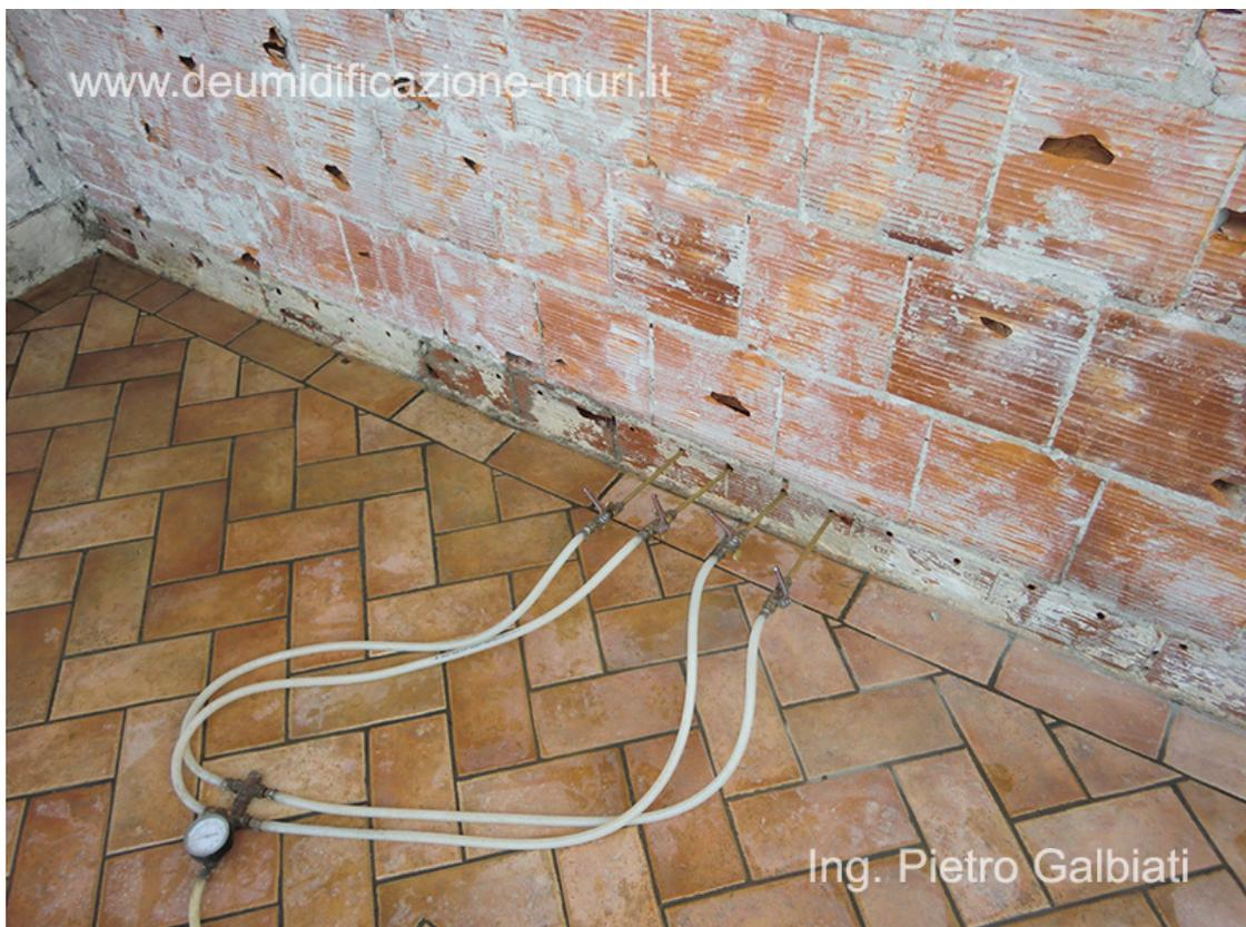
Barriera chimica mediante iniezioni di resine silconiche su una muratura in blocchi forati in laterizio, operando dall'esterno, dopo la rimozione dell'intonaco ammalorato.
