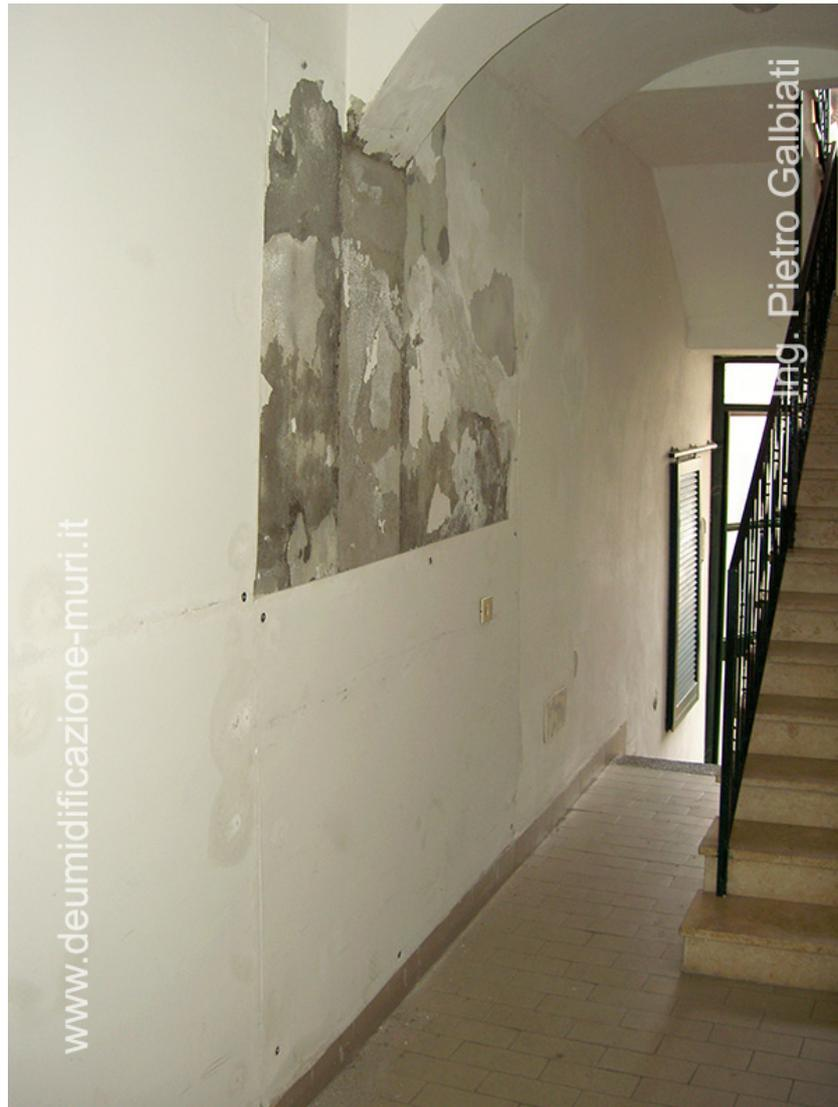
La realizzazione di una controparete in cartongesso può solo nascondere il problema dell'umidità di risalita. In questo caso le lastre in cartongesso sono state fissate direttamente alla muratura senza l'utilizzo degli appositi profili in alluminio.
