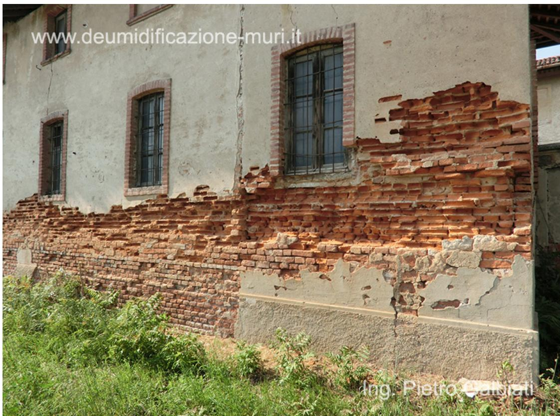
Danni causati dall'umidità di risalita: distacco della stabilitura, dell'intonaco e deterioramento dei materiali costituenti la muratura (mattoni pieni in laterizio e malta).
