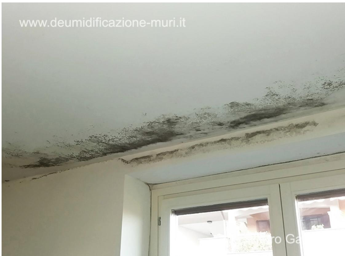
Formazione di muffa per la presenza di condensa superficiale in corrispondenza dei ponti termici tra serramento, muratura e solaio.
