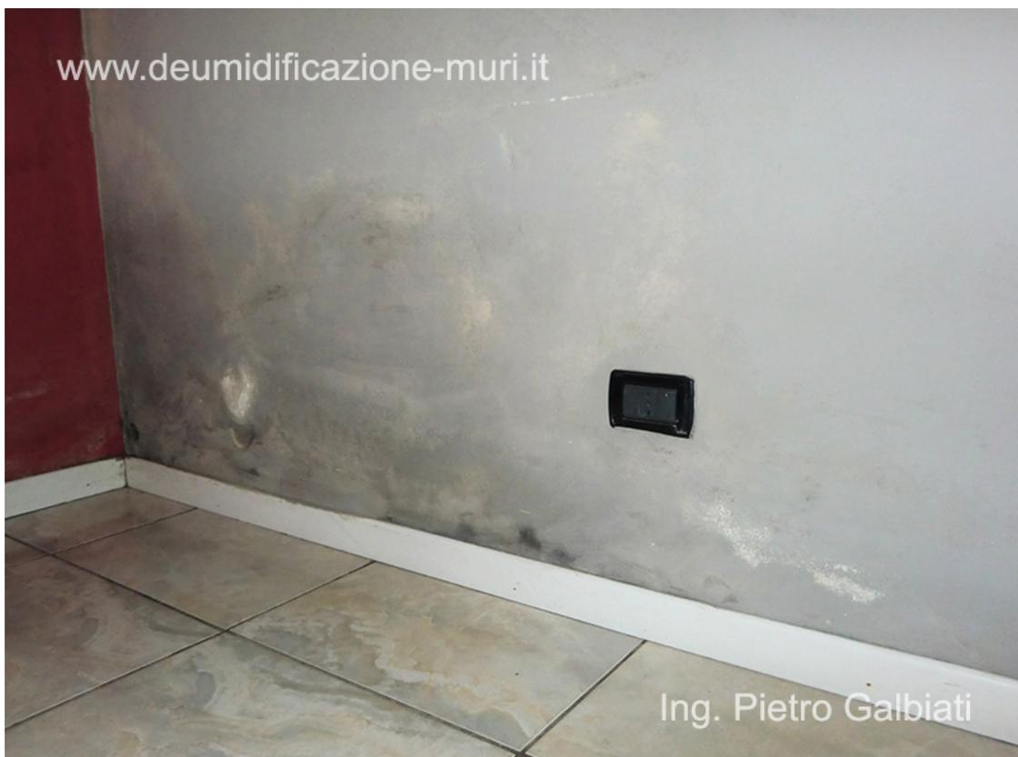
Un intonaco deumidificante può solo rallentare il degrado causato dall'umidità di risalita.
