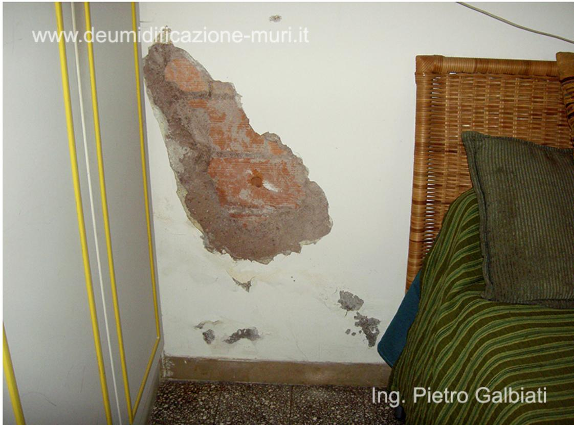
Danni causati dall'umidità di risalita: distacco della tinteggiatura, della stabilitura e dell'intonaco.
