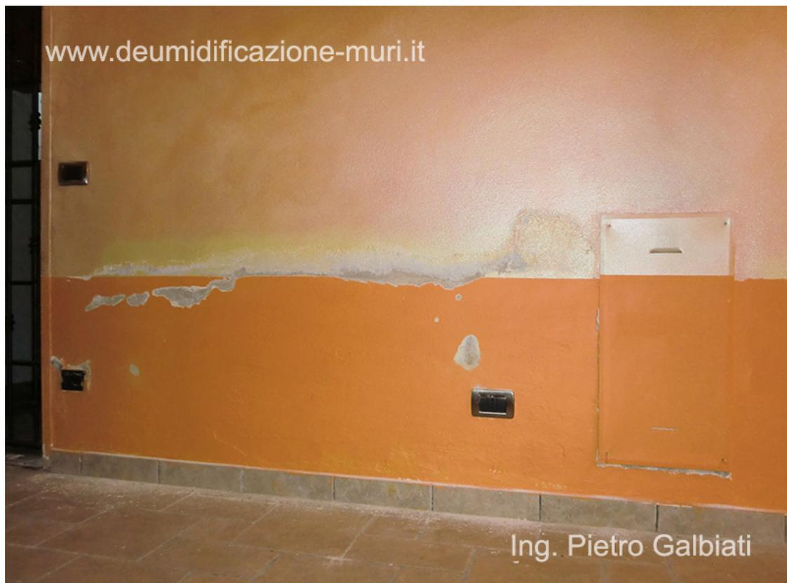
L'applicazione di una pittura (di qualsiasi tipologia) può solo nascondere nel breve periodo il problema dell'umidità di risalita. In questo caso è stata applicata una pittura idrorepellente e non traspirante; il degrado infatti si presenta dove inizia la pittura tradizionale.
