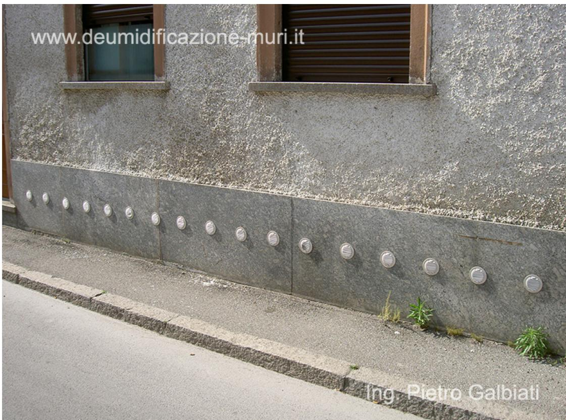
Il rivestimento in lastre di granito alla base della muratura, la realizzazione di fori di aerazione e la stollatura della superficie superiore della muratura sono riusciti a nascondere il problema dell'umidità di risalita. Ma come sarà la situazione sul lato interno della muratura?
