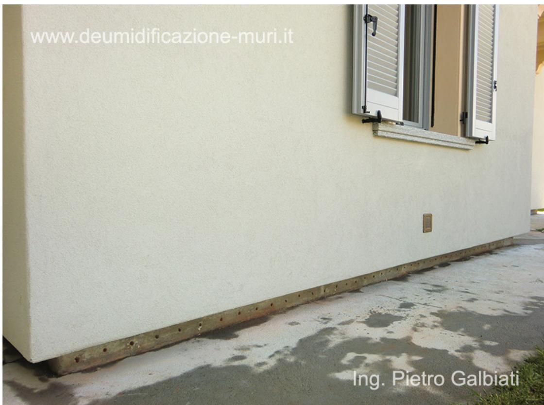
L'applicazione di un cappotto sul lato esterno di una muratura può solo nascondere il problema dell'umidità di risalita.
