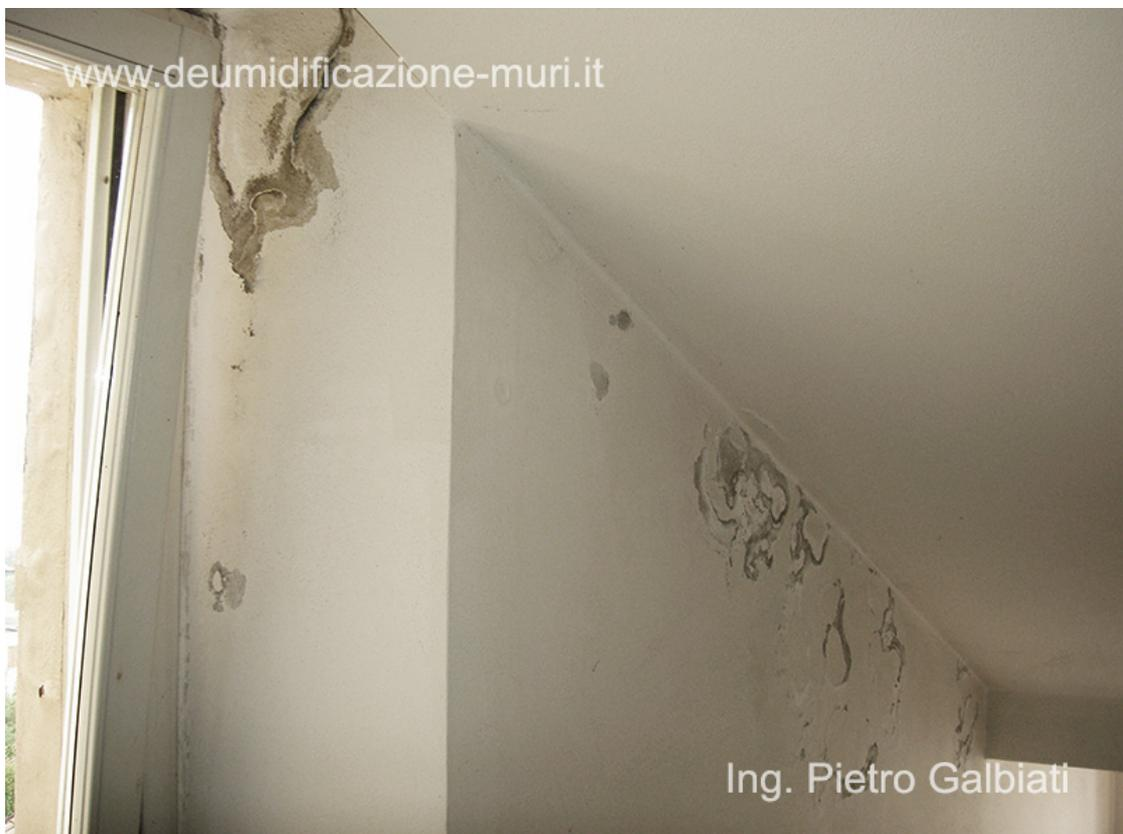
Infiltrazione di acqua piovana in un vano scale.
