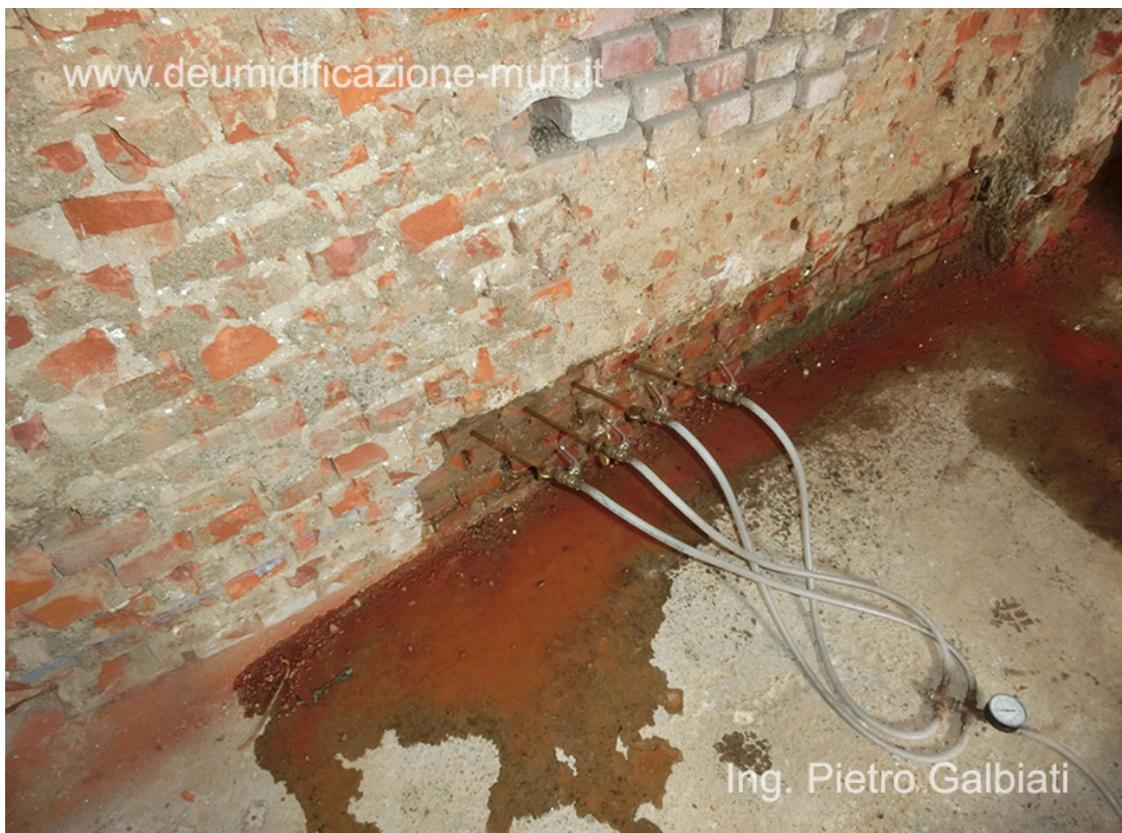
Barriera chimica mediante iniezioni di resine silconiche su una muratura in mattoni pieni in laterizio, operando dall'interno, dopo la rimozione dell'intonaco ammalorato.
