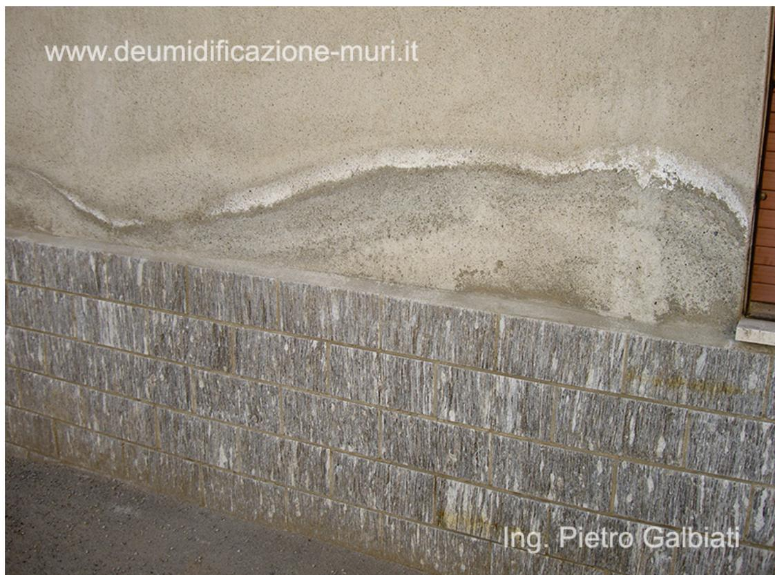
Qualsiasi intonaco, anche se miscelato con appositi additivi, è destinato a deteriorarsi nel tempo a causa dei sali contenuti nell'acqua proveniente dal terreno.
