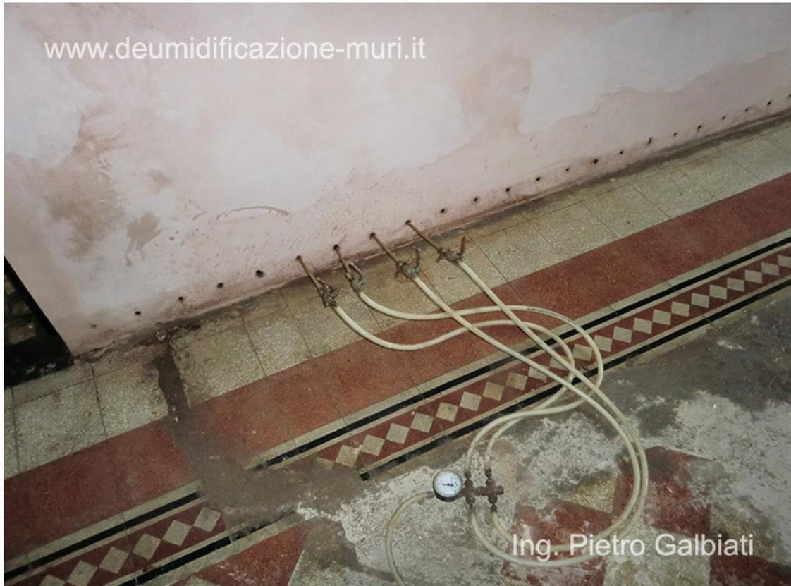
Barriera chimica mediante iniezioni di resine silconiche su una muratura in mattoni pieni in laterizio e sassi, operando dall'interno, prima della rimozione dell'intonaco ammalorato.
