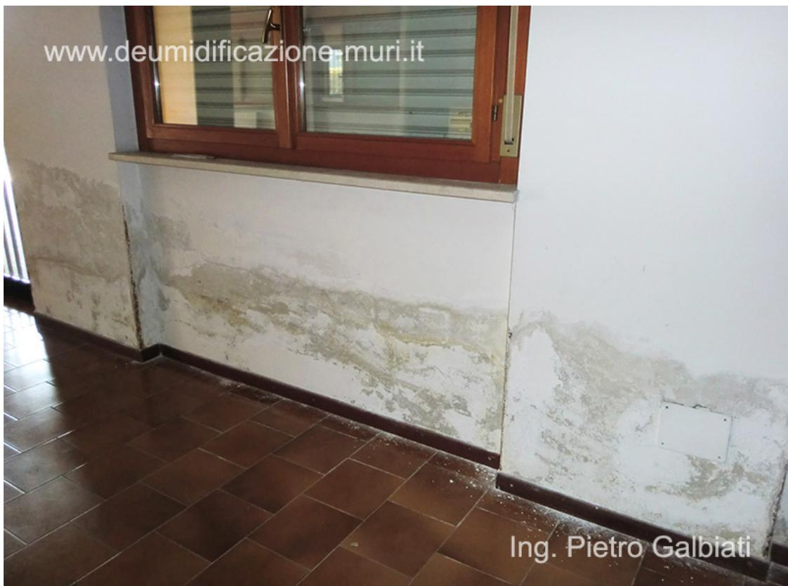
Danni causati dall'umidità di risalita: distacco della tinteggiatura e della stabilitura.
