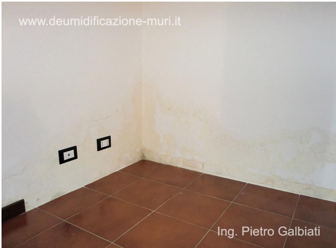
Danni causati dall'umidità di risalita: ingiallimento della tinteggiatura, distacco della tinteggiatura.
